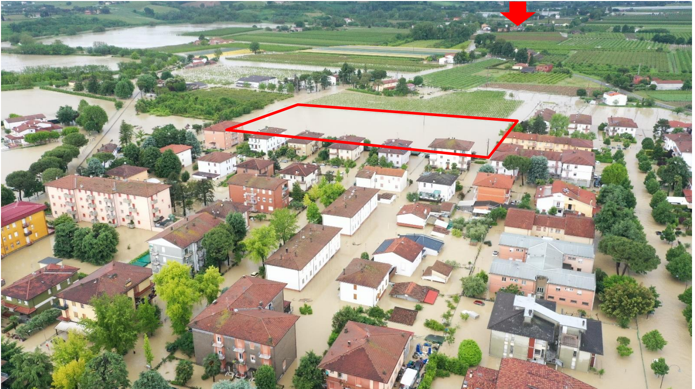
FOTO RIPRESA IN DATA 17/05/2023 ALLE ORE 6:30 DEL MATTINO – LA FRECCIA ROSSA INDICA LA POSIZIONE DELLA PRINCIPALE ROTTURA DELL'ARGINE DEL FIUME SENIO – IL CONTORNO ROSSO INDICA L'AREA DI PROGETTO
